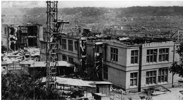
図10 地震直後の中学関東学院本校舎被害（北西側）
