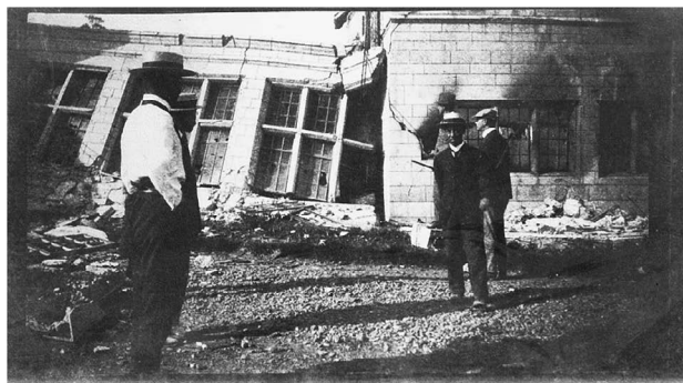
倒壊した建物を調査する坂田祐と役員
