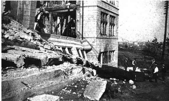
図12 地震直後の本校舎東棟の被害（南側）
