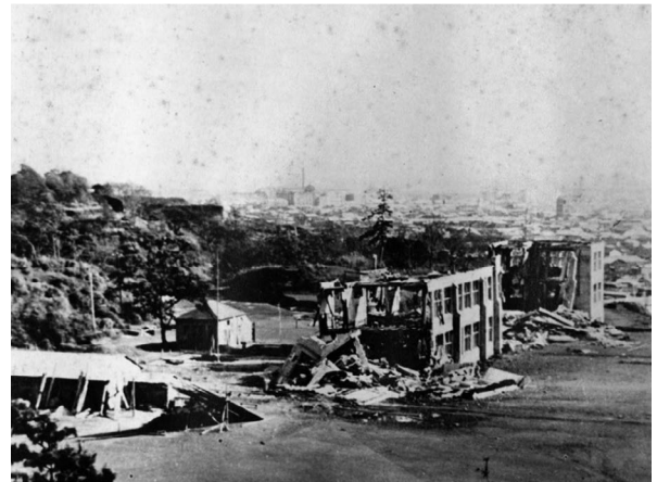
図14 本校舎被害（南西側）
