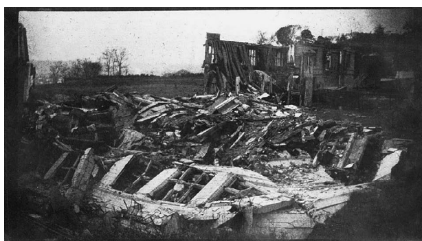
倒壊した本校舎
