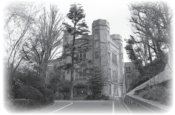
解体前(2012年)の中学旧本館 (1992年 横浜市認定歴史的建造物に指定)
