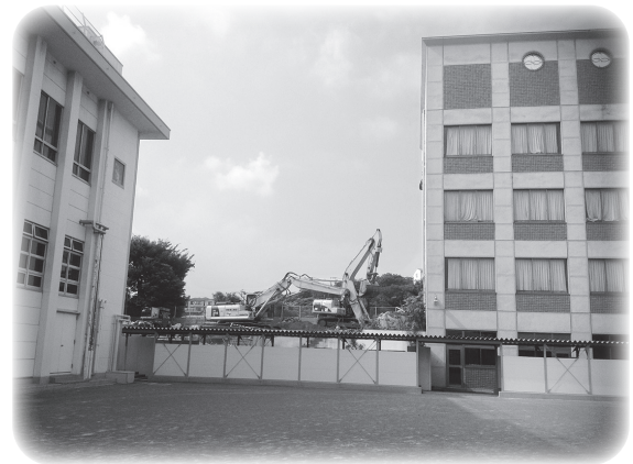
新校舎着工(2013年8月)
