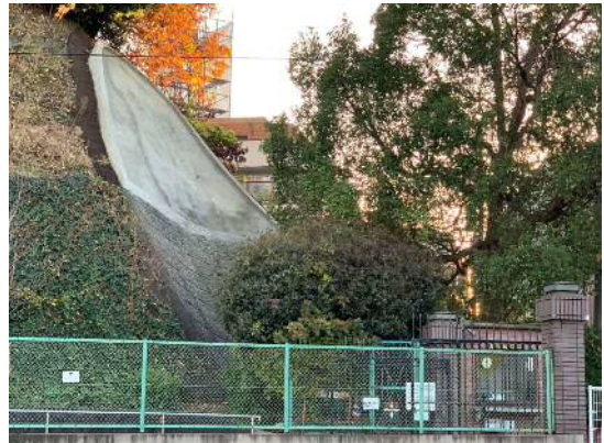
(2) 中学校高等学校 正門裏側法面整備工事
