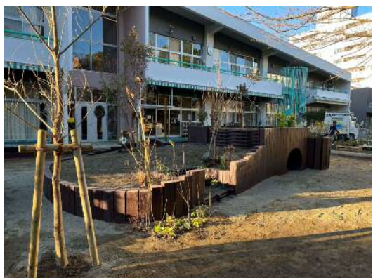
(4) のびのびのば園 園庭部分改修工事
