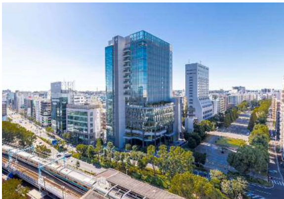
(1) 大学 新棟建設工事
