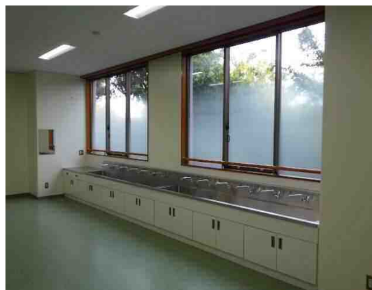
(4) 小学校 教室棟2階造形室改修工事
