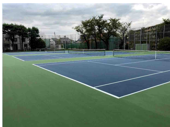
(2) 中学校高等学校 テニスコート更新工事
