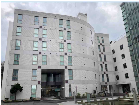
(1) 大学 経済学館外壁・屋上防水改修工事
