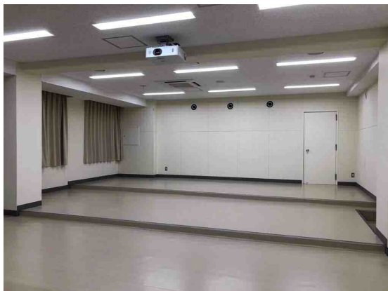
(3) 六浦中学校・高等学校 本館3・4階他改修工事
