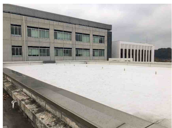
(4) 六浦小学校 体育館・講堂屋上防水更新工事
