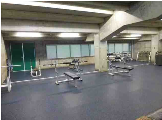
(1) 大学 野球場トレーニングルーム他改修工事
