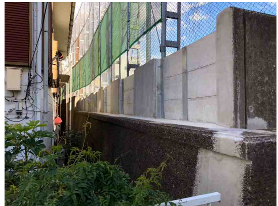
(2) 中学校高等学校 テニスコートブロック擁壁改修工事
