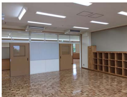
(4) 小学校 教室棟 3 階内部改修工事
