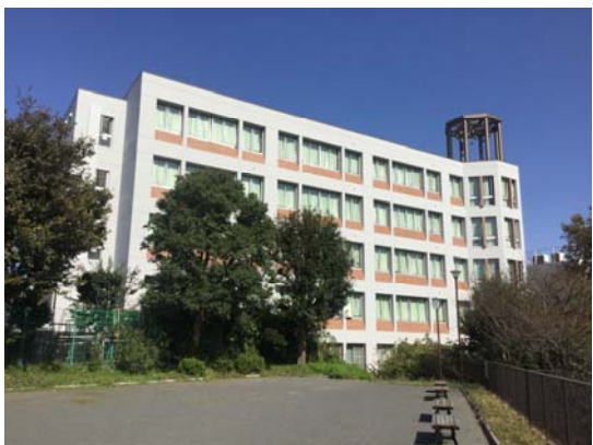
(3) 中学校高等学校 高等学校本館外壁補修工事
