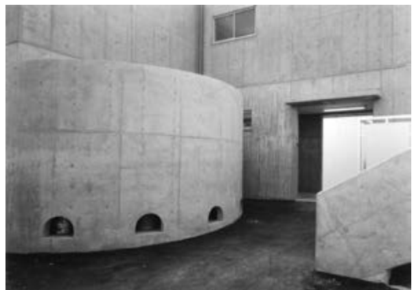
連絡通路及びプロパン庫 (B棟)
