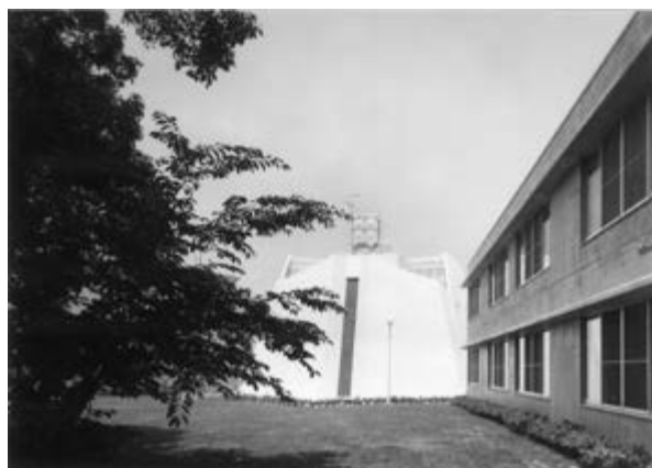
中庭側外景（B棟側より）
