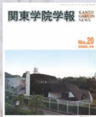
正面本館外壁が黒色で塗装された写真
