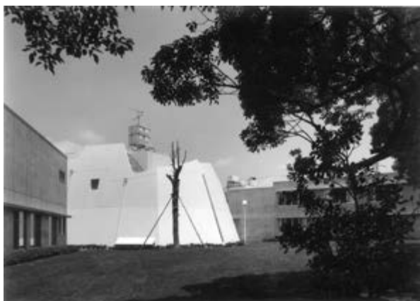
中庭側外景（A棟側より）
