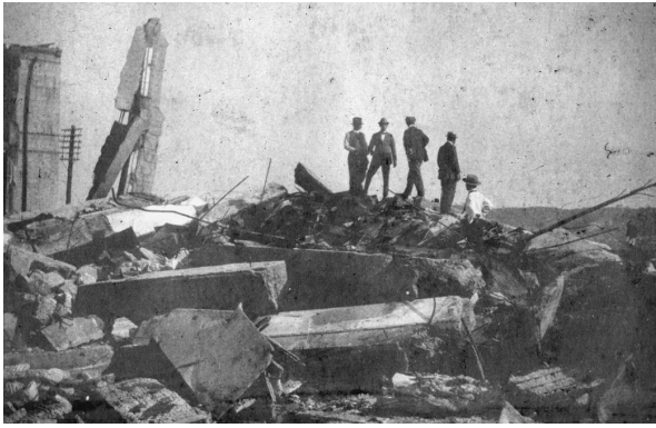
震災の被害にあった校舎
