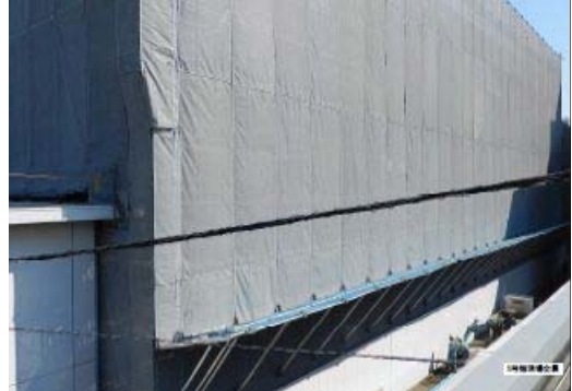
5号館現場全景
