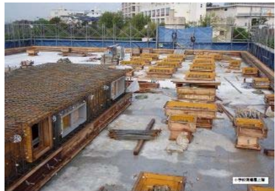
小学校現場屋上階
