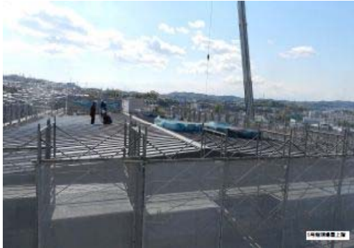
5号館現場屋上階
