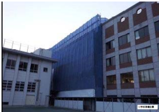
小学校現場全景
