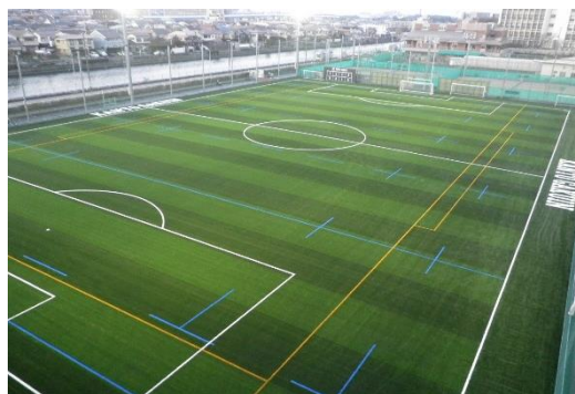
関東学院アストロフィールド全景
