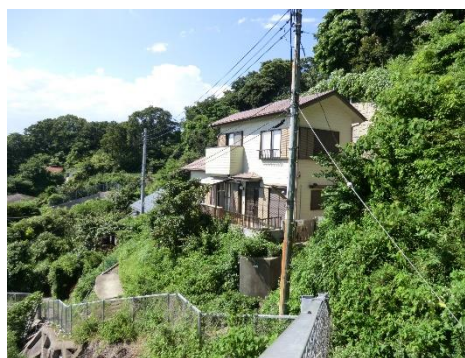
改修予定の住宅
